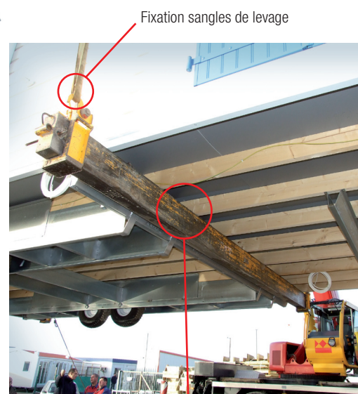
Barre de levage perpendiculaire aux lambourdes et proche de la partie centrale métallique.
